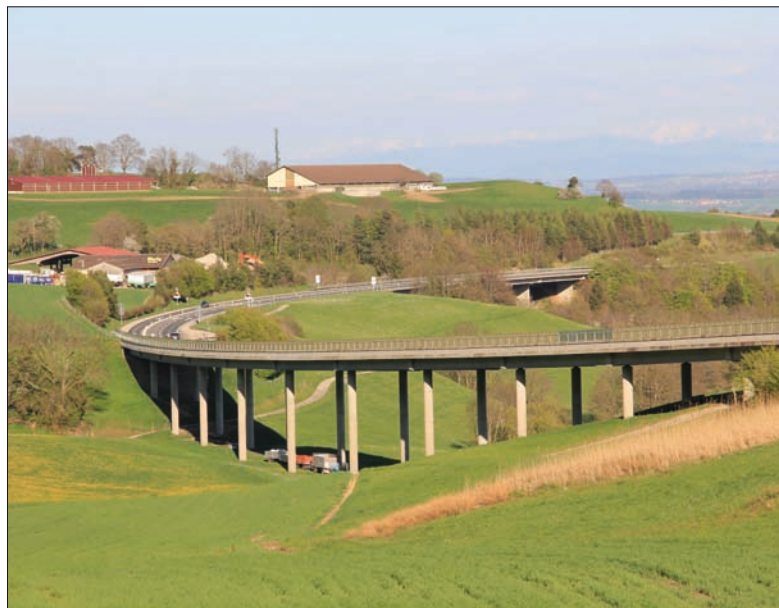
Le pont de l'autoroute AgB près de Lignerolle.
